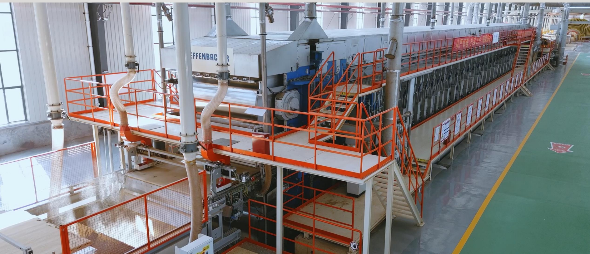
Directional paving 定向铺装
